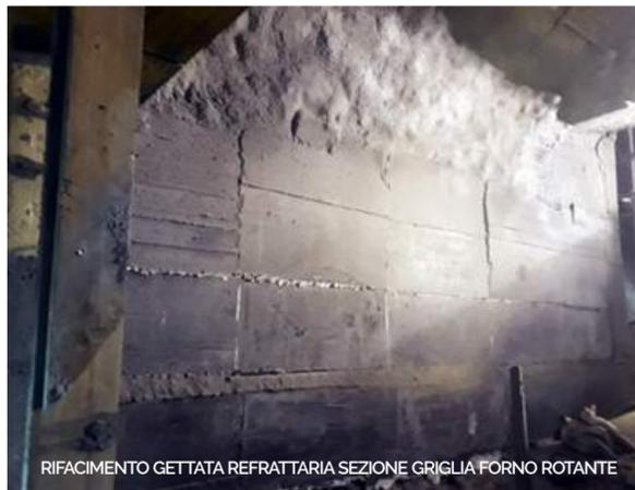
RIFACIMENTO GETTATA REFRATTARIA SEZIONE GRIGLIA FORNO ROTANTE
